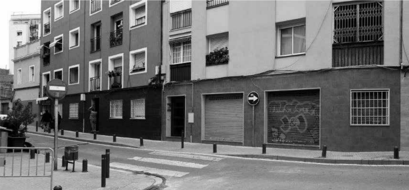
El carrer Pirineus renovat.
