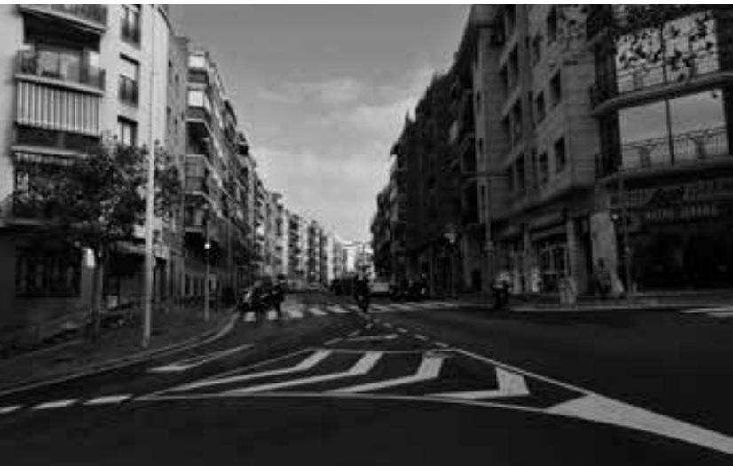
L'Avinguda dels Banús després de les obres.
