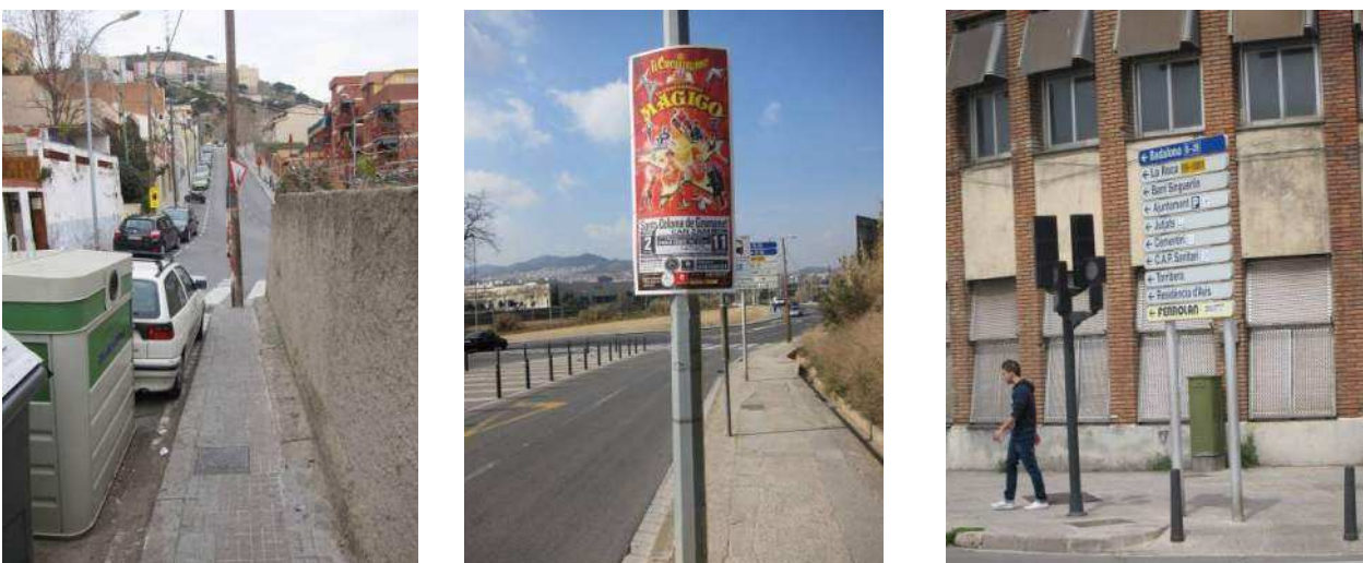
Figura 5.7: Exemples de defectes de la senyalització vertical Font: Fotos pròpies
