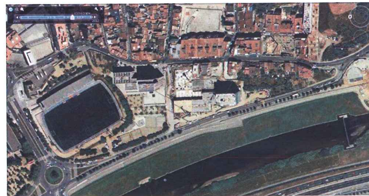
Execució Fase II del Front Fluvial del Raval. Ortofoto de data 31-12-2009 (Font: Google Earth).
