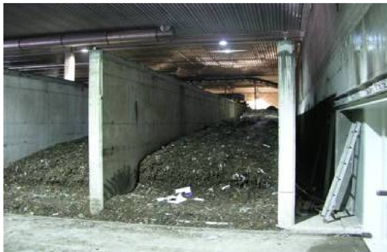
Estabilització en trinxeres
