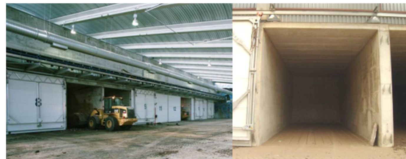
Túnels de compostatge
