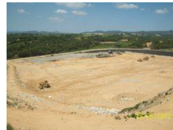
Vista general zona activa
