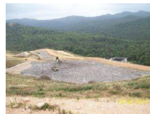
Vista general zona activa
