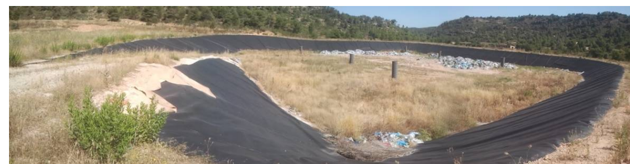
Vista general zona activa
