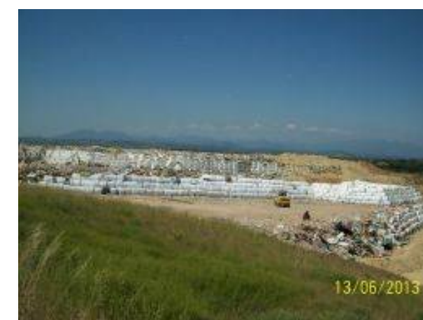
Vista general zona activa
