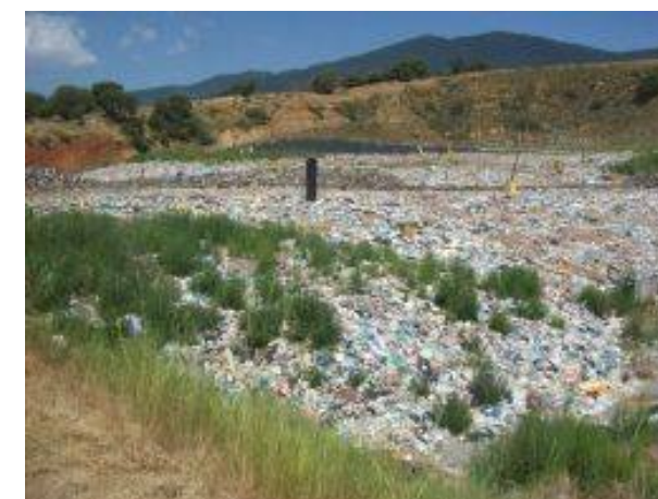
Vista general zona activa
