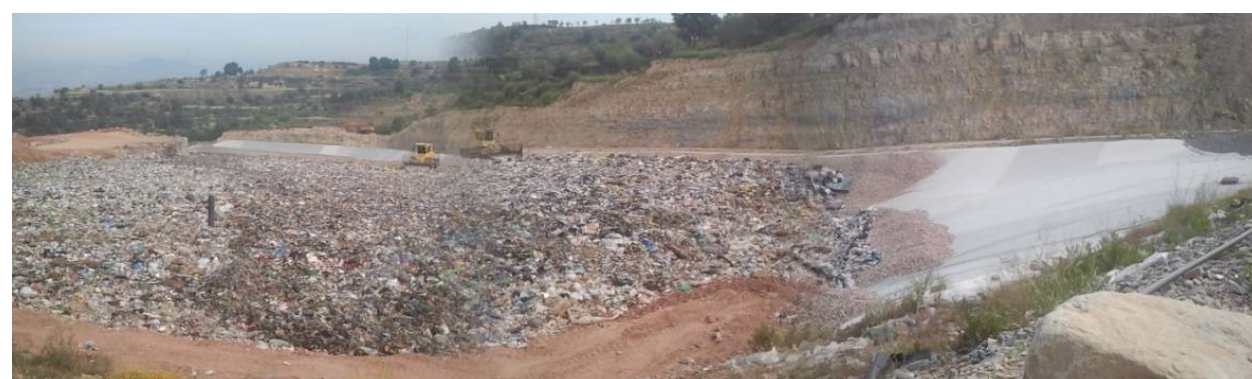
Vista general zona activa
