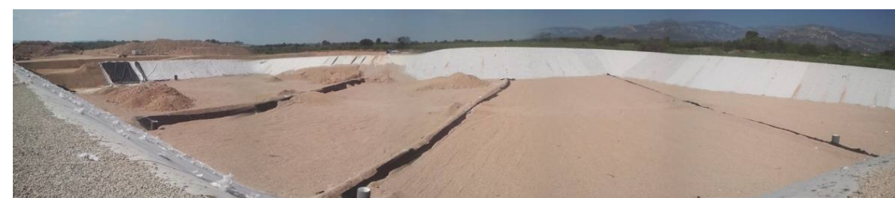
Vista general zona ampliada
