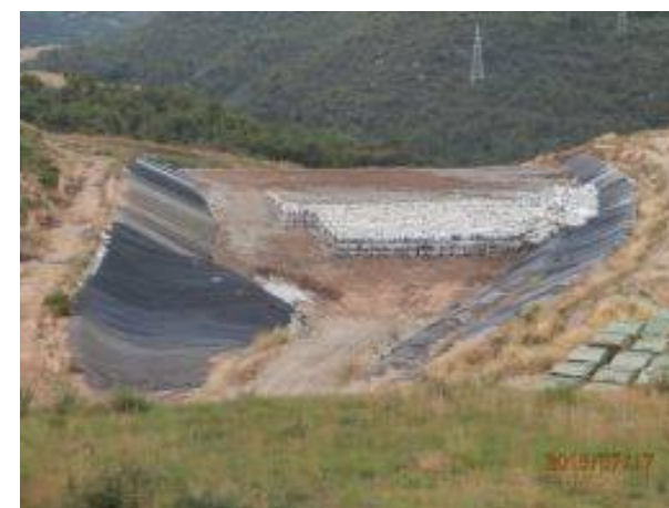
Vista general zona activa
