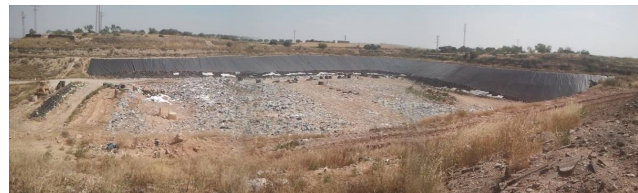
Vista general zona activa
