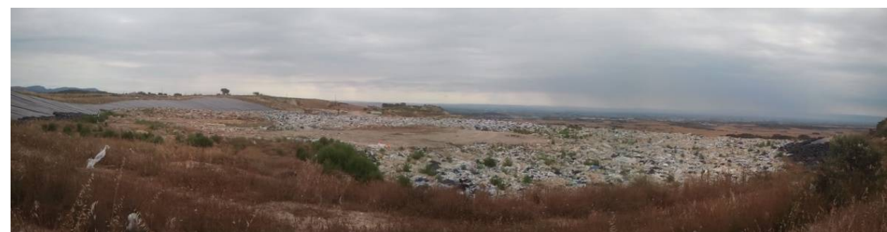
Vista general zona activa
