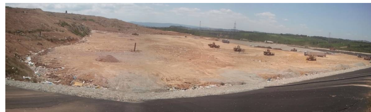
Vista general zona activa
