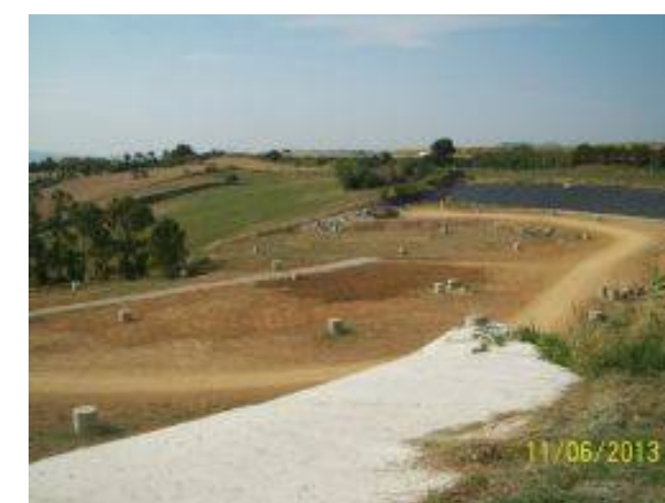
Vista general zona activa
