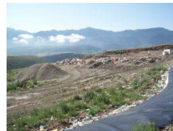
Vista general zona activa
