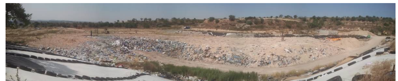
Vista general zona activa
