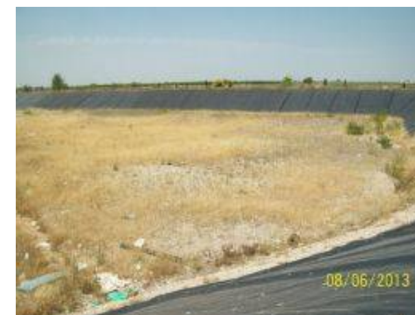
Vista general zona activa
