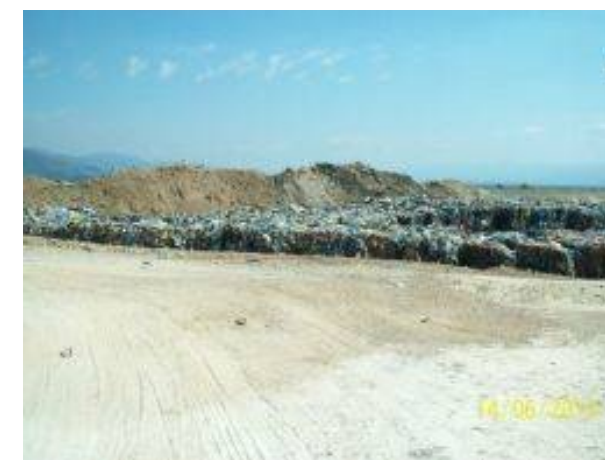
Vista general zona activa
