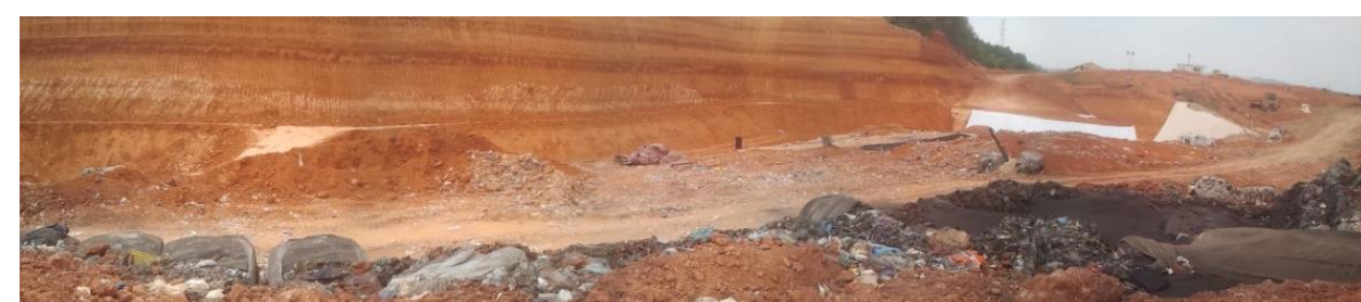
Vista general zona activa
