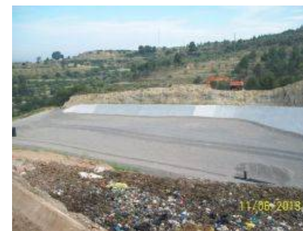
Vista general zona ampliada
