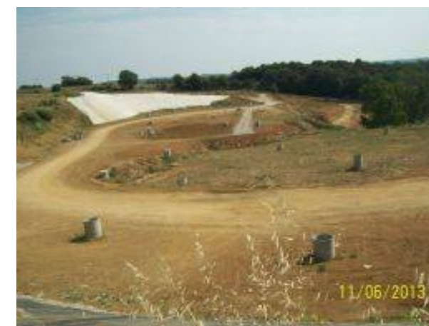
Vista general zona activa
