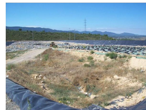
Vista general zona activa
