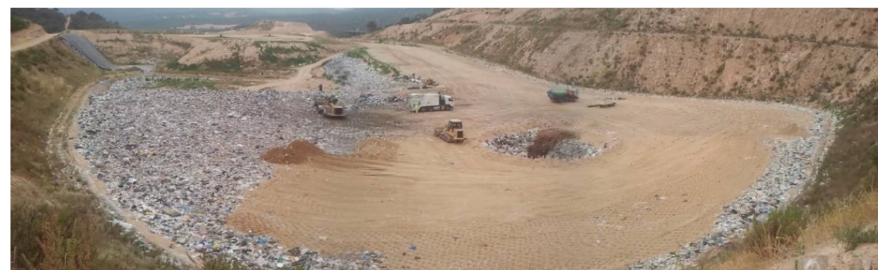
Vista general zona activa
