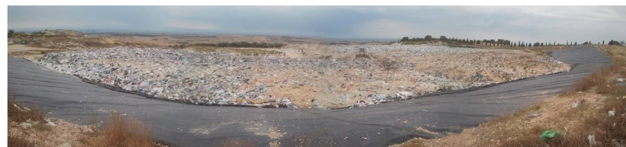
Vista general zona activa
