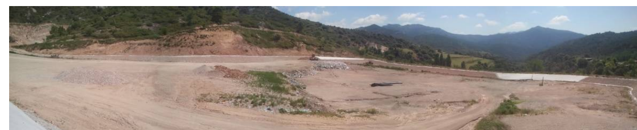
Vista general zona activa
