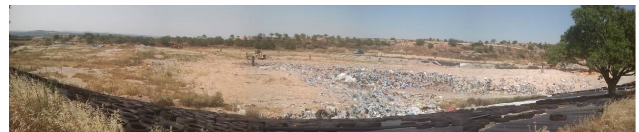
Vista general zona activa
