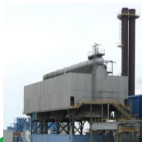
Aerocondensadors
