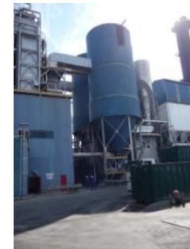
Absorbidor i sitges de carbó actiu i calç
