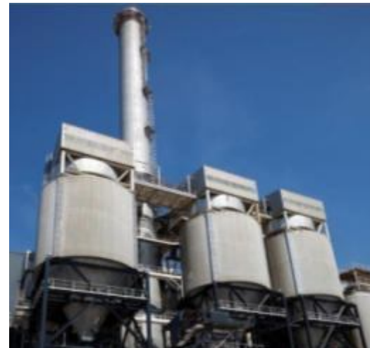
Absorbidor de gasos àcids
