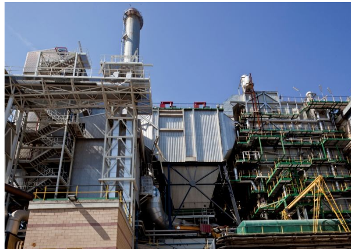
Equipament depuració de gasos
