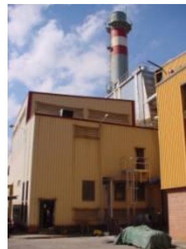
Edifici de turbina
