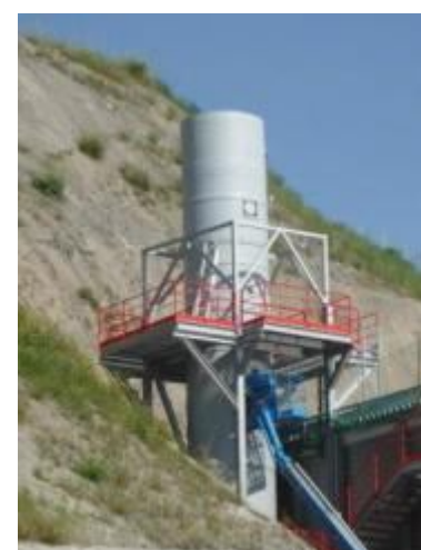
Xemeneia biofiltre
