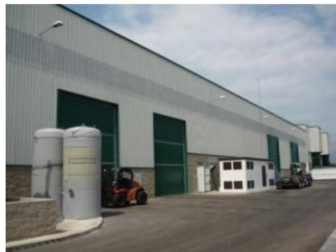
Accés nau de recepció i pretractament
