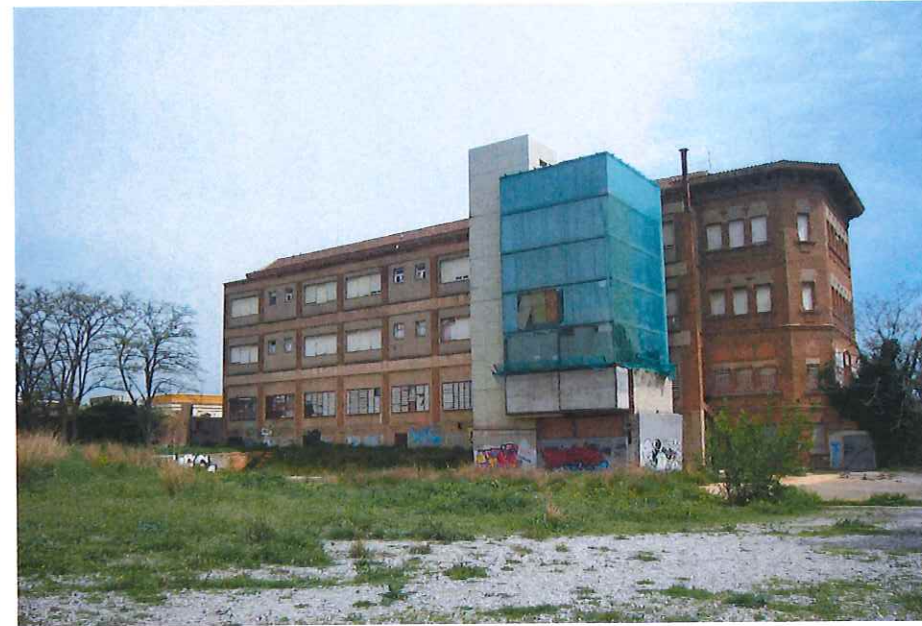
10. Pavelló B, façana oest
