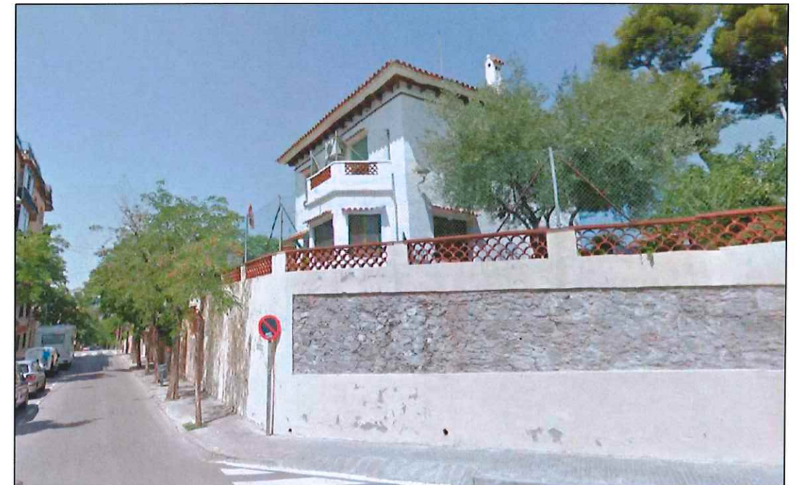
Fotografies de l'edificació existent
