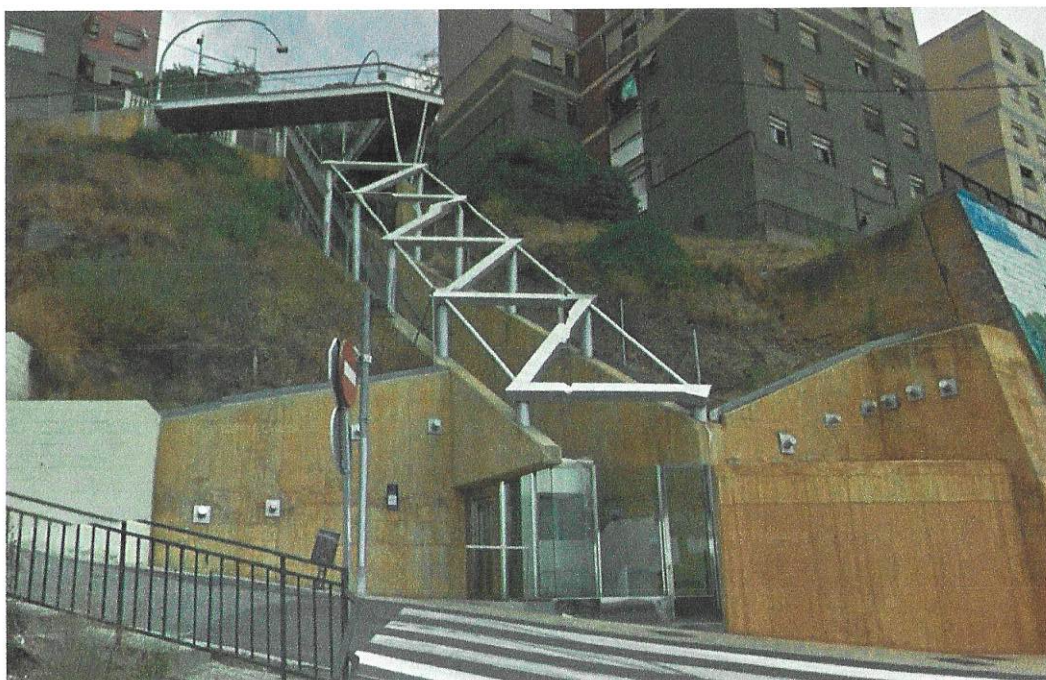
Fotografia ascensor inclinat instal·lat entre els C/Formentera i C/Menorca al barri de Can Franquesa. Font: Google Earth
