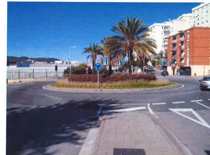
Imatge 8. Entrada a la rotonda des de l'est per l'Avinguda Francesc Macià.
