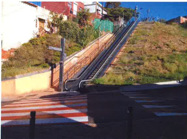
Imatge 22. Escales mecàniques i pas de vianants entre el carrer Sants i el carrer Tarragona.
