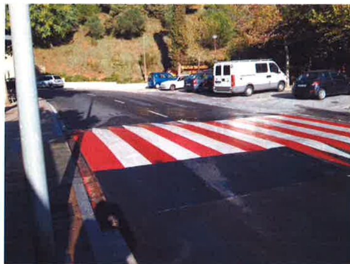
Imatge 29. Pas de vianants de ressalt a la Ctra. de la Font de l'Alzina, a l'alçada de la Plaça Che Guevara.
