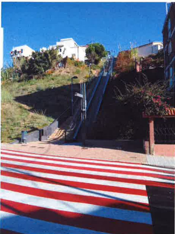
Imatge 23. Escales mecàniques i pas de vianants entre la Ctra. de la Font de l'Alzina i el carrer Sants.
