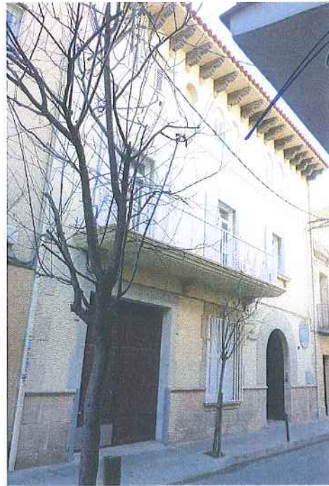
Carrer del Pedró 10. Can Altés Fitxa de patrimoni EC-20
