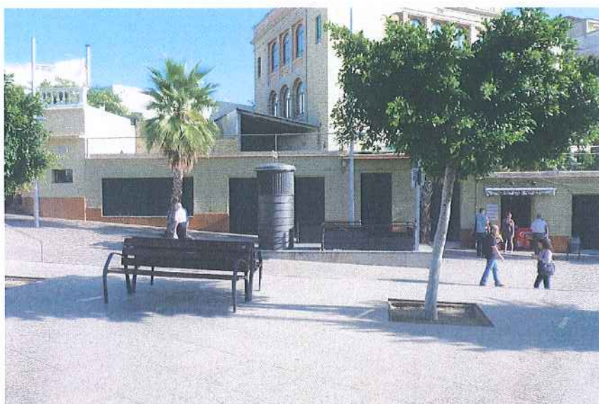
Plaça de la Vila 5, 6, 7 i 7bis. Els nùms 5 i 6 es corresponen als locals enderrocats. Els núm 5 compta amb un forat allargassat (aparador) i dos forats que es corresponen a les portes de l'antiga botiga Confecciones Alcaide. El núm 6 amb dos forats (portes) és on havia estat la Perruqueria Ferrer. El tendal es correspon al núm. 7 dedicada a la venda de llaaminadures i l'obertura següent a la dreta (tallada a la foto) al 7bis, actualment desocupat.
