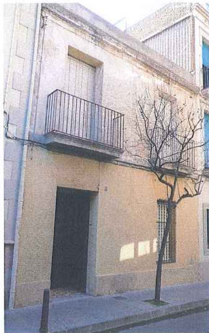
Carrer del Pedró 8. Can Serra
