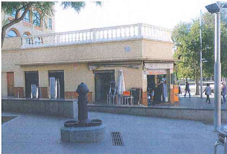
Vista del Bar Xocolà en la part corresponent al carrer del Pedró. Entrada pel xamfrà, plaça de la Vila 4.
