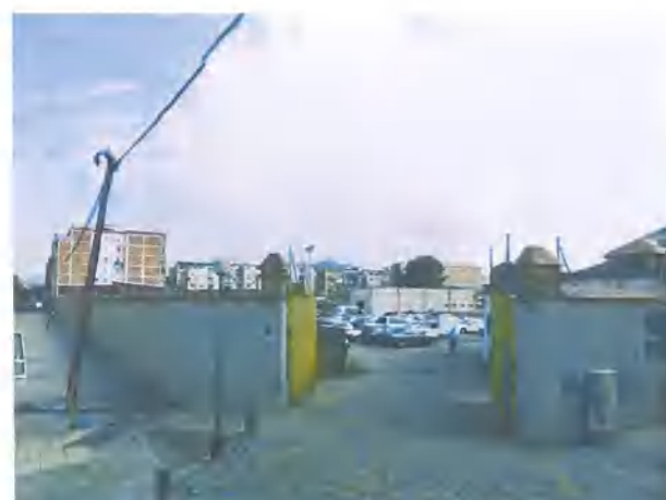
Accés instal·lacions Agbar
