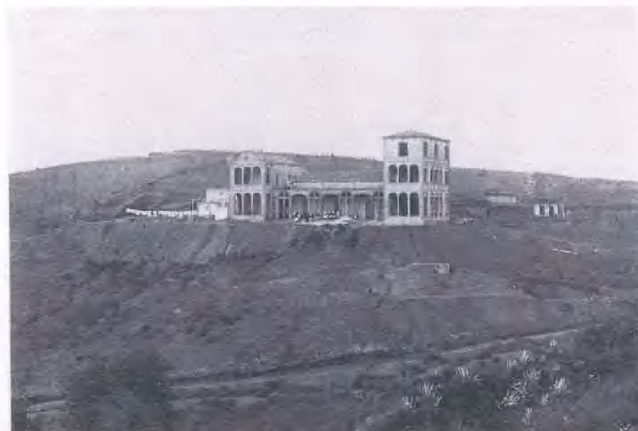
Pavelló de dones tuberculosos del Sanatori de l'Esperit Sant, construït l'any 1922.
