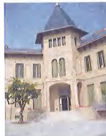
Can Roig i Torres
