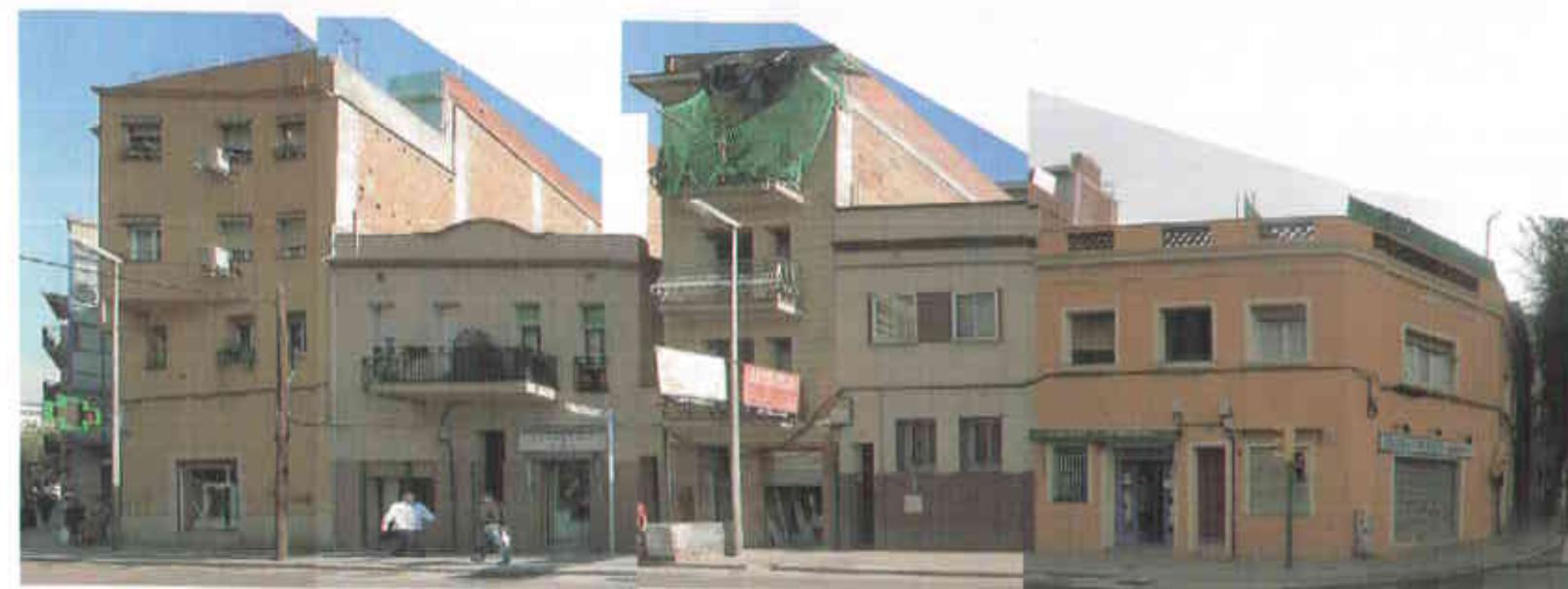
Front façana Av. Generalitat entre Carrer Roger de LLuria i Carrer de Sant Jordi
