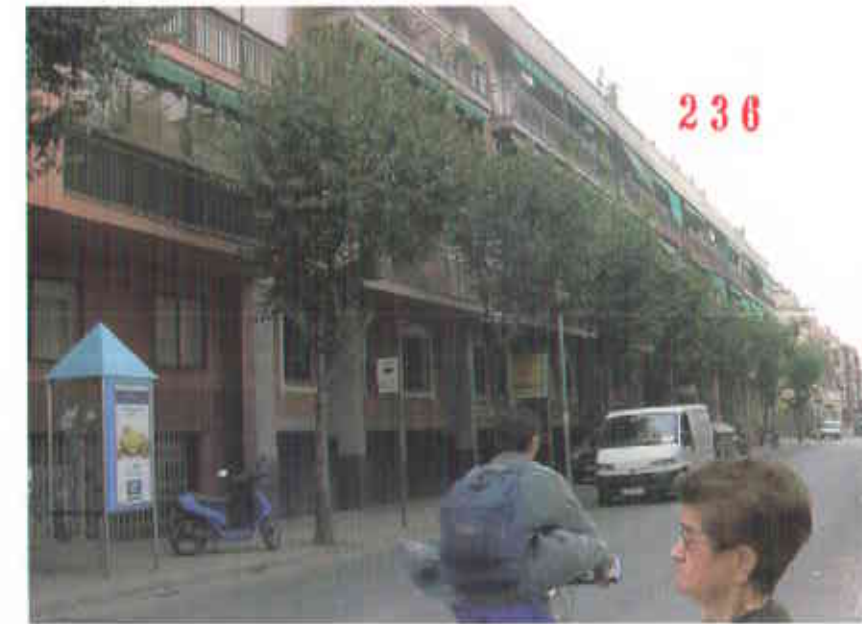
Front façana Av. Generalitat entre Carrer de Sant Jordi i Carrer de Pau Claris
