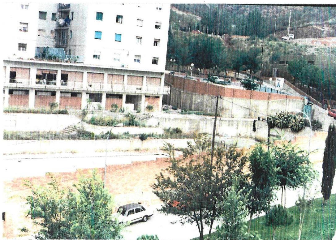
Parte alta solar, casi a nivel con semisotanos bloque, futuras vestuarios actualmente topiados, acceso a la derecha
