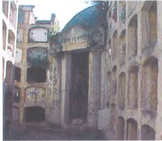
Estat previ al desmuntatge
