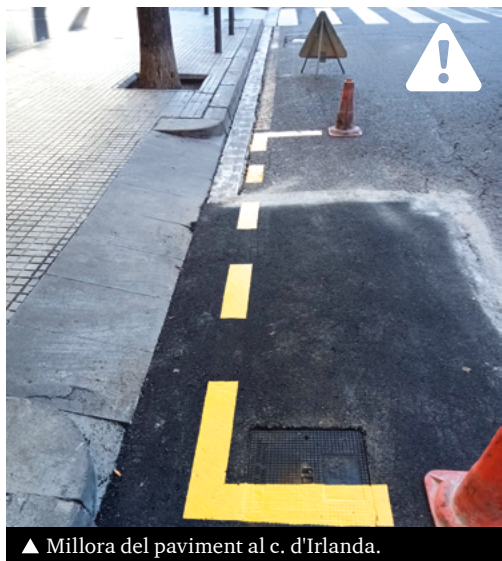
▲ Millora del paviment al c. d'Irlanda.
