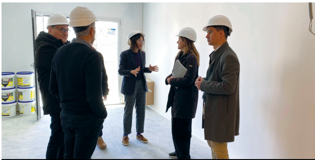
▲ Visita institucional a les obres dels habitatges del complex Les Oliveres.
