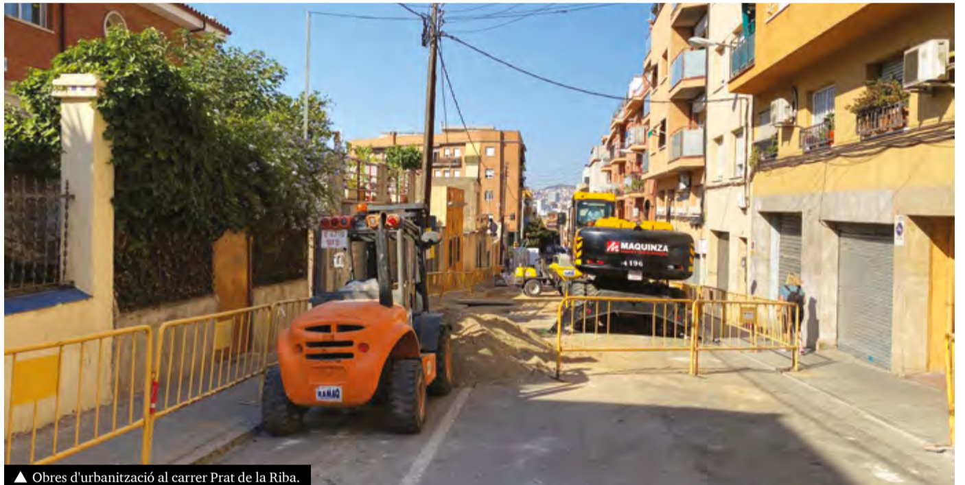
▲ Obres d'urbanització al carrer Prat de la Riba.
