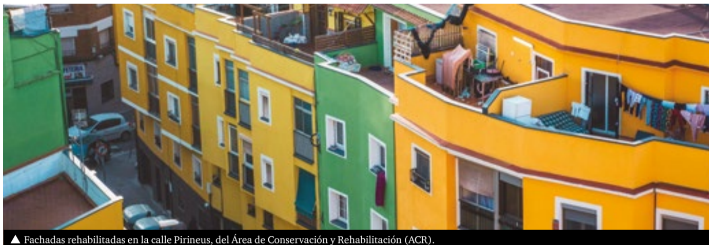
▲ Fachadas rehabilitadas en la calle Pirineus, del Área de Conservación y Rehabilitación (ACR).
