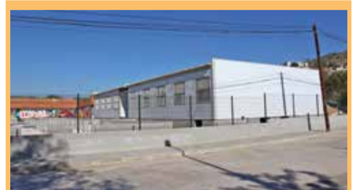
EN MARXA ELS MÒDULS DE L'INSTITUT SANTA COLOMA La Generalitat segueix treballant en les obres d'instal·lació i adequació dels mòduls provisionals de l'Institut Santa Coloma. Aquests acolliran l'alumnat fins a la construcció de l'edifici definitiu.
