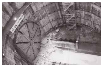
El presidente de la Generalitat y el alcalde de Santa Coloma, entre otras personalidades, asistieron a la operación de llegada de la tuneladora que construye el metro al pozo de bifurcación del Besòs, momento que se aprecia en la foto de abajo.
