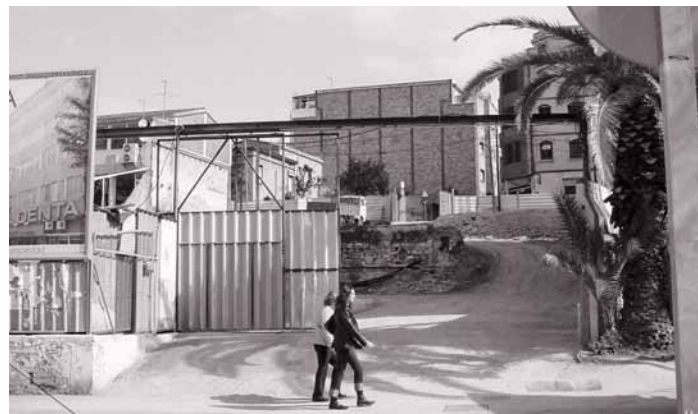
Arriba, un plano que detalla cómo será la apertura del paseo de Mossèn Jaume Gordi hacia la rambla de Sant Sebastià. Abajo, una vista de las obras desde la rambla.
