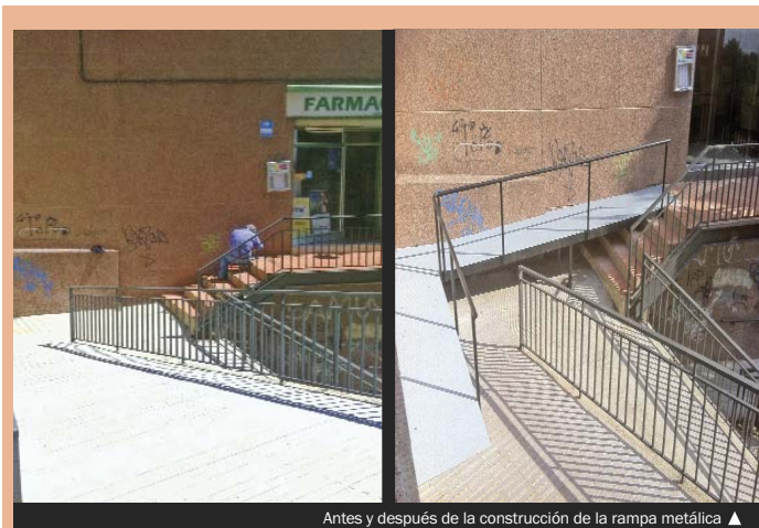
Antes y después de la construcción de la rampa metálica ▲
