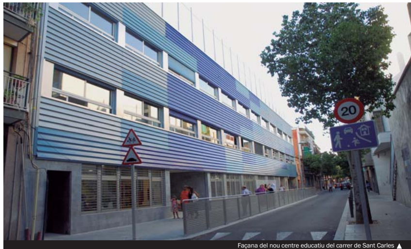
Façana del nou centre educatiu del carrer de Sant Carles ▶
