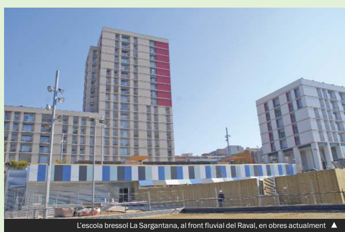
L'escola bressol La Sargantana, al front fluvial del Raval, en obres actualment ▲
