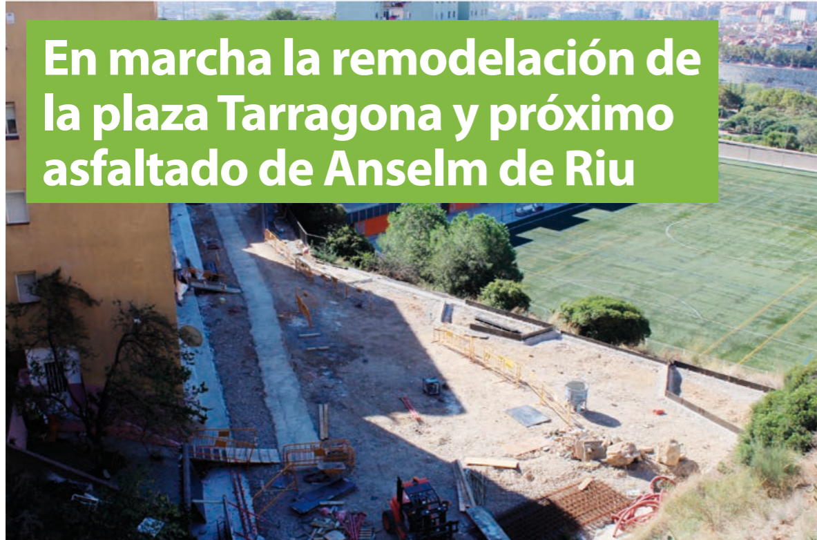
▲ Obras en la Plaza Tarragona.
