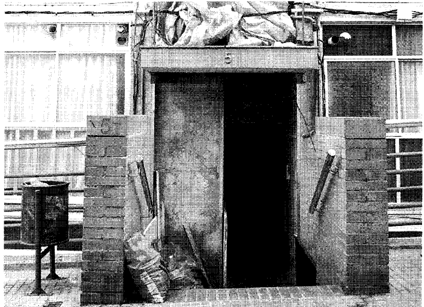
Imatge de la instal·lació d'un ascensor al barri colomenc de les Oliveres. / I.MARTÍNEZ
