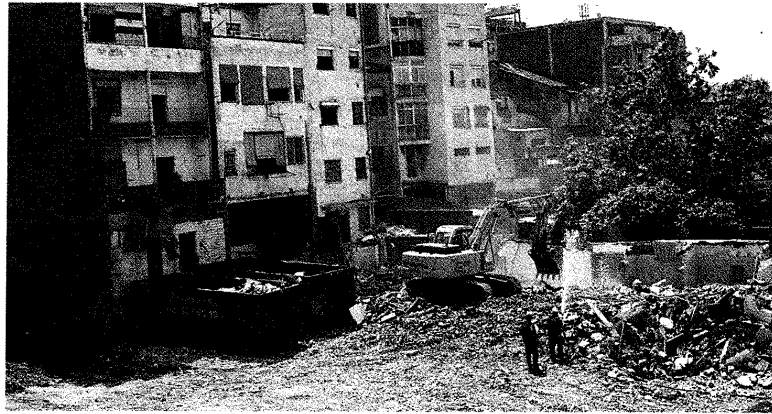
Derribo de barracones. El plan del Ayuntamiento prevé demoler las antiguas viviendas edificadas durante el desarrollismo y edificar en su lugar nuevos pisos y un rascacielos
