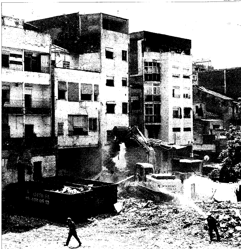
►► Inicio de los derribos de los viejos bloques de pisos del frente fluvial del Besòs, ayer.
