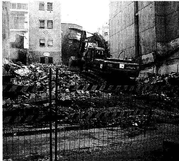
Imatge de les obres per fer l'estació de metro. /I.M.
