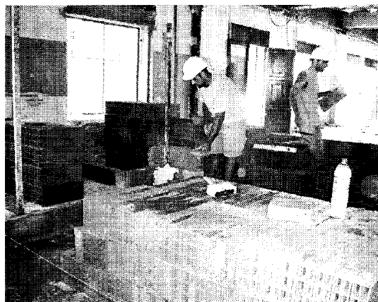
Operaris treballant a l'interior del CEIP Sagrada Família. / I.M.
