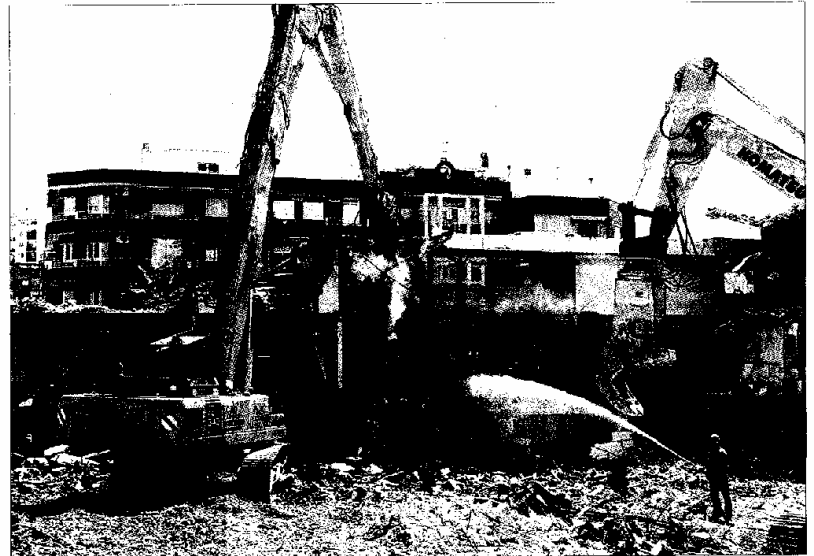
►► Trabajos de derribo del exterior del viejo mercado del Fondo, ayer.
