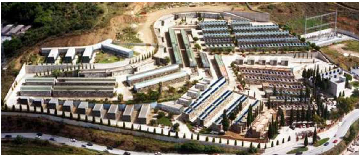
+Vista aèria del cementiri municipal, amb la instal·lació de plaques fotovoltaïques
